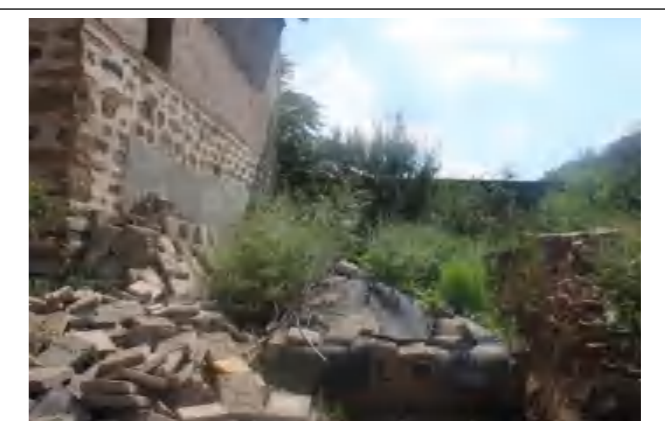
舞楼和东山门南侧现状
