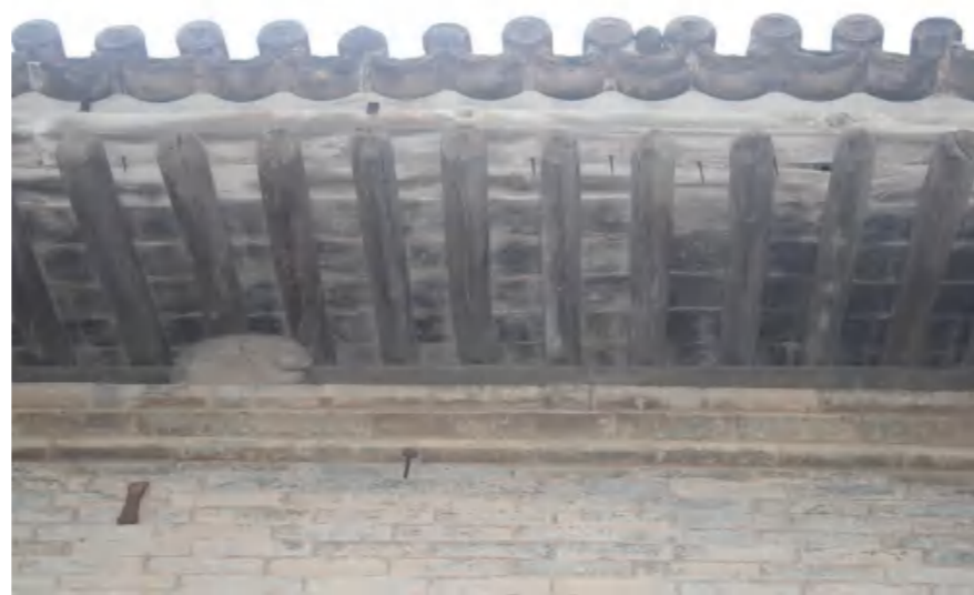
照片 5：后檐椽合计 17 根糟朽、开裂，且椽头 60%朽裂。
