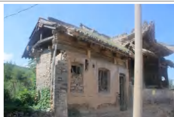
后人增砌前檐墙现状
