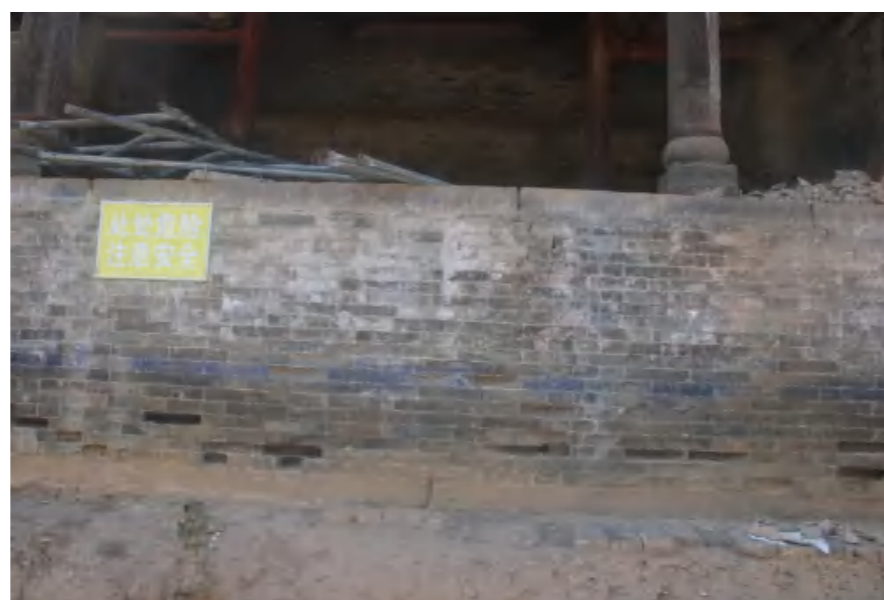
照片 32：台基砖合计约 58 块砖酥碱（碱深 \geq 2\text{cm} ）。
