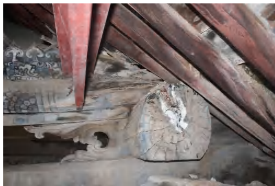
照片 5：后檐椽合计 17 根糟朽、开裂，且椽头 60%朽裂。
