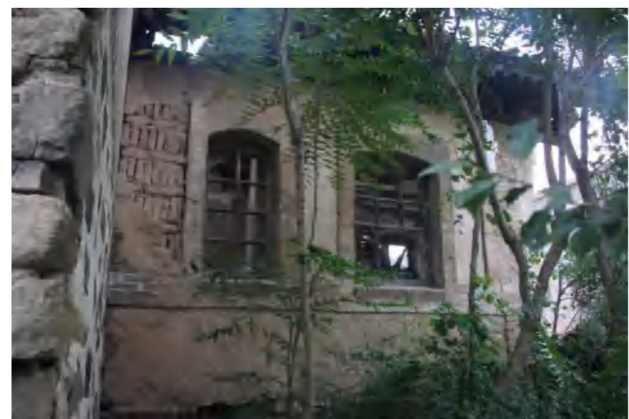
照片 11：后人增砌后檐墙现状。
