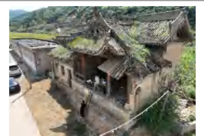
舞楼现状照片
