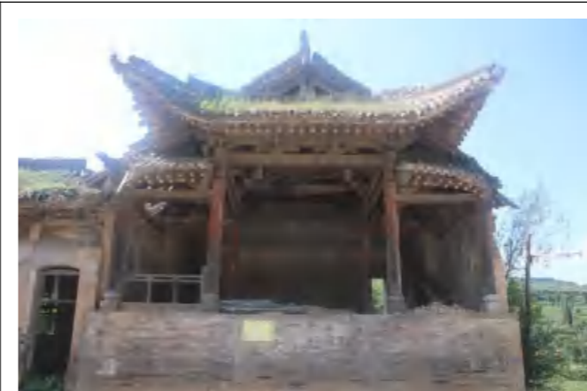
舞楼正立面照片
