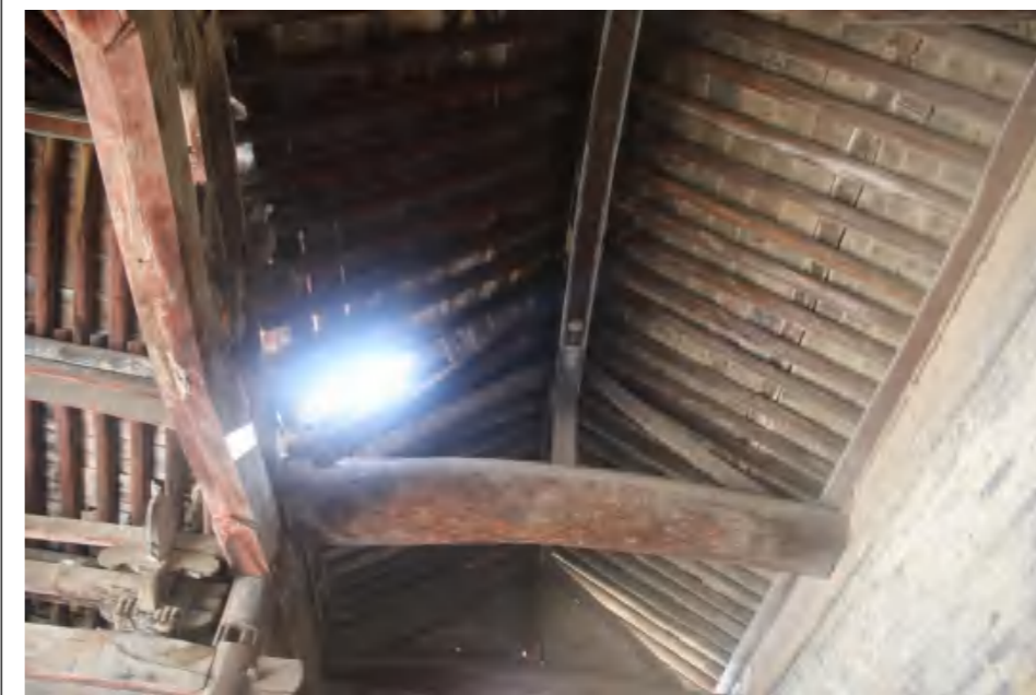
照片 6：西山三架梁室外部分均糟朽、劈裂严重。
