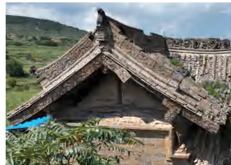
照片 6：西山三架梁室外部分均糟朽、劈裂严重。
