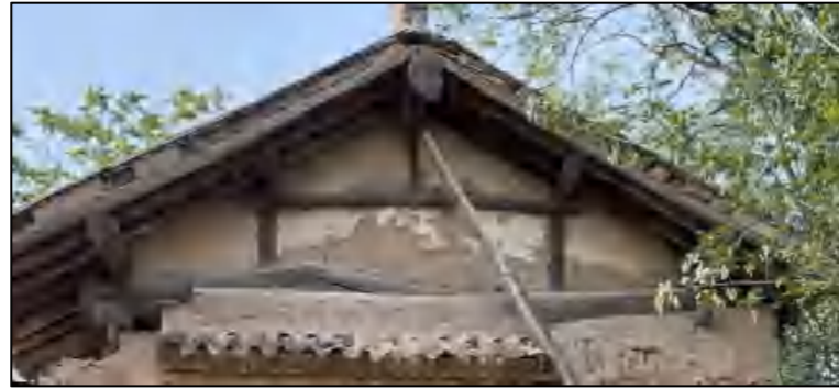
东配殿梁架结构
