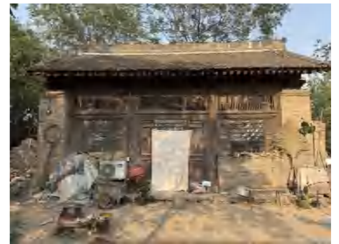
东配殿正立面
