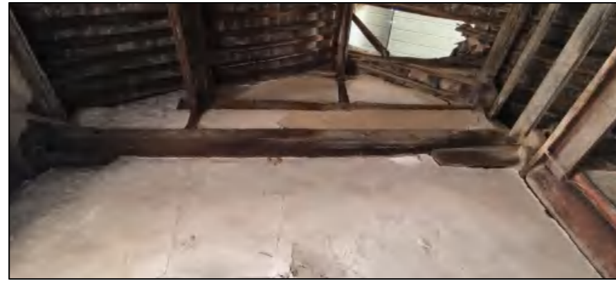
正殿梁架结构
