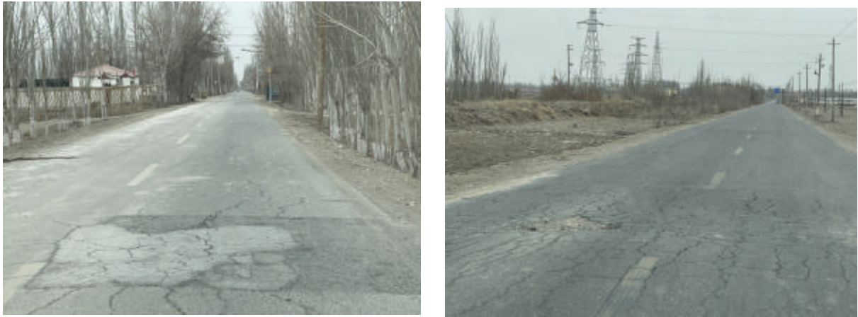
块状裂缝、龟裂
