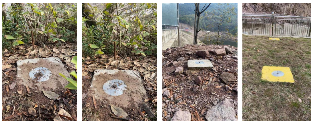
现场水平位移工作基点照片
