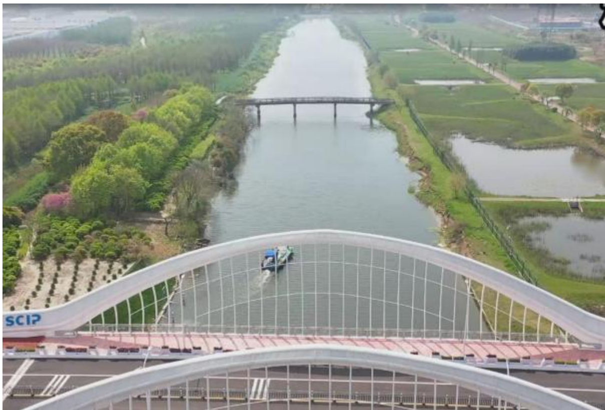
海思路南侧坍塌段
